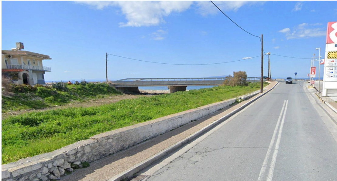
Σχ. 1.3 Απεικόνιση του χείμαρρου και του υφιστάμενου κύριου οδικού δικτύου στο σημείο εκβολής στην θάλασσα (Πηγή: Google Street View, Ιούνιος 2025)
